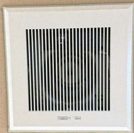
CO 2 センサー付換気扇取付け
